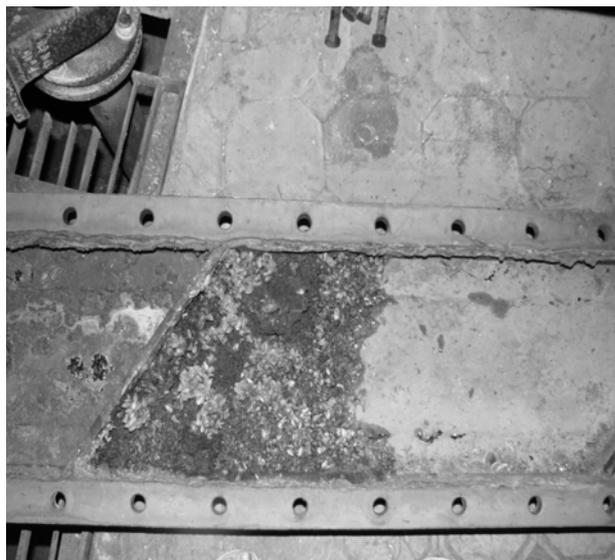
Рис. 2. Поверхность до нанесения защитного покрытия
