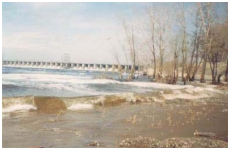
Рис. 3. Волнение в нижнем бьефе Жигулевского гидроузла, возникающее при попусках через водосливную плотину
