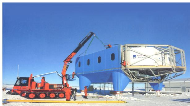
**Рис. 2.** Британская исследовательская станция в Антарктиде «Halley VI». На фото стадия строительства одного из модулей этой станции
