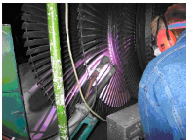
**Рис. 3.** Восстановление рабочих лопаток 29 ступени ротора паровой турбины на ТЭЦ (г. Новокуйбышевск) плазменным напылением на мобильной установке. Восстановление проводится на лопатках ротора без разборки турбины при вскрытой крышке цилиндра низкого давления
