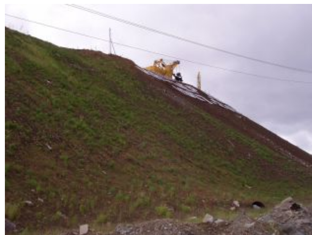
Рис. 2. Отвал после проведения биологической рекультивации
