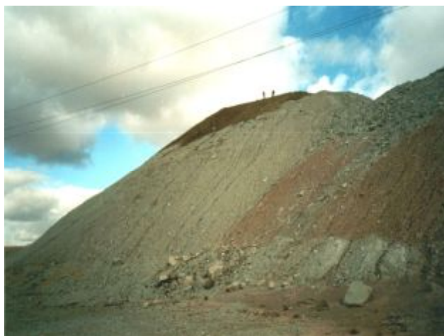
Рис 1. Отвал №6 до рекультивации
