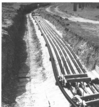
Рис. 10. Укладка в траншею кабелей двух КЛ-110 кВ
