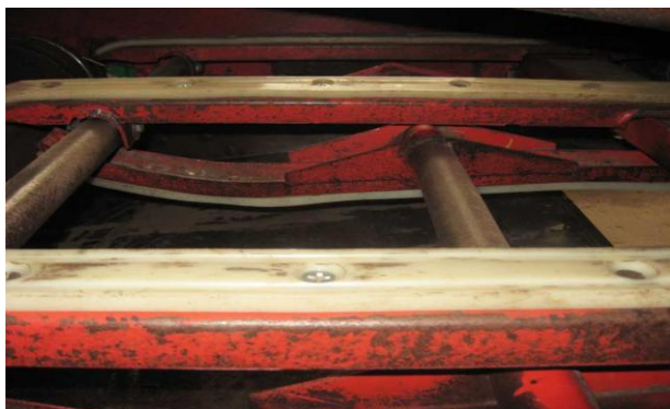
Рис. 2. Накладки после замены
