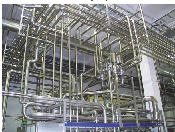
**Рис. 1. Фрагмент технологического трубопровода предприятия пищевой промышленности**
