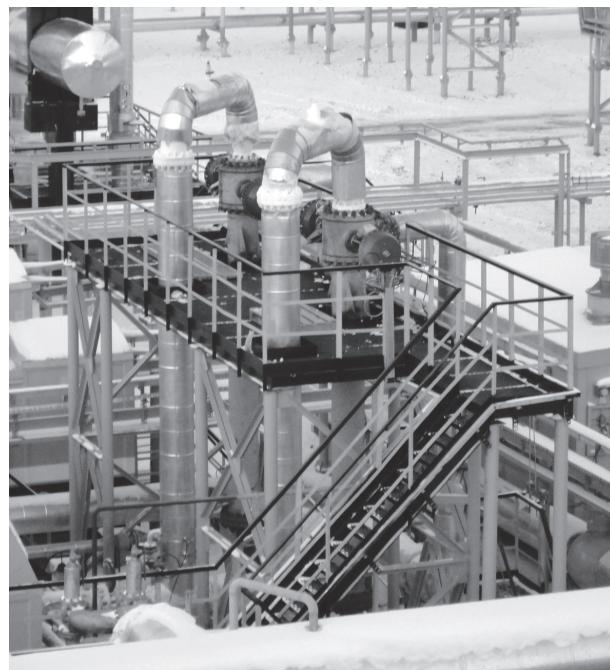
**Рис. 5.** Внешний вид высокопроизводительных ТВТ
