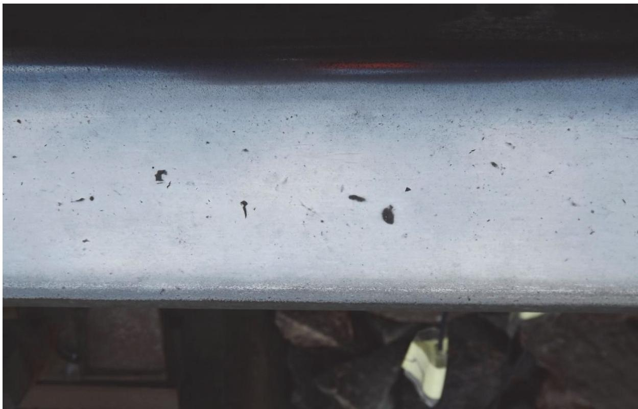
Рис. 4. Поверхности катания рельсов до шлифования
