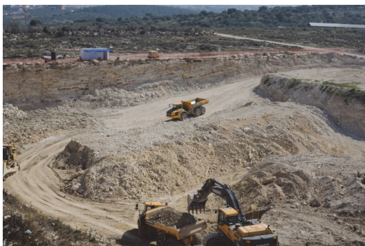
Рис. 4. Строящаяся ячейка – будущий полигон ТБО
