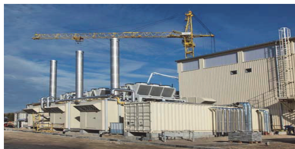
Рис. 3. Мусороперерабатывающий комплекс с оборудованием на основе плазменно-дугового реактора по Канадским технологиям
