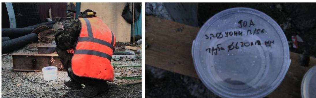
Рис. 1. Способ отбора проб во время сварки
