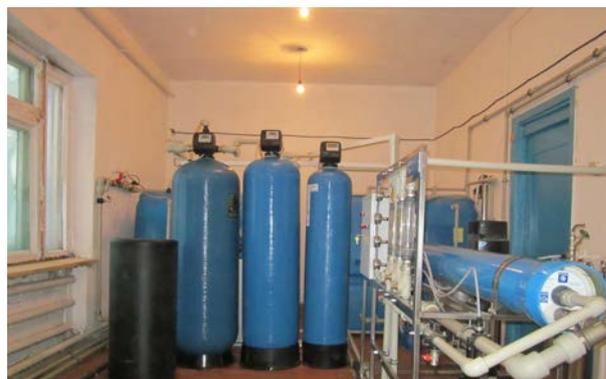
**Рис. 2.** Малогабаритная станция очистки сточных вод «ЛИССКОН-301»
