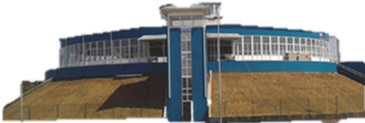
Рис. 3. Фото очистных сооружений хозяйственно-бытовых сточных вод «Суворовские»
