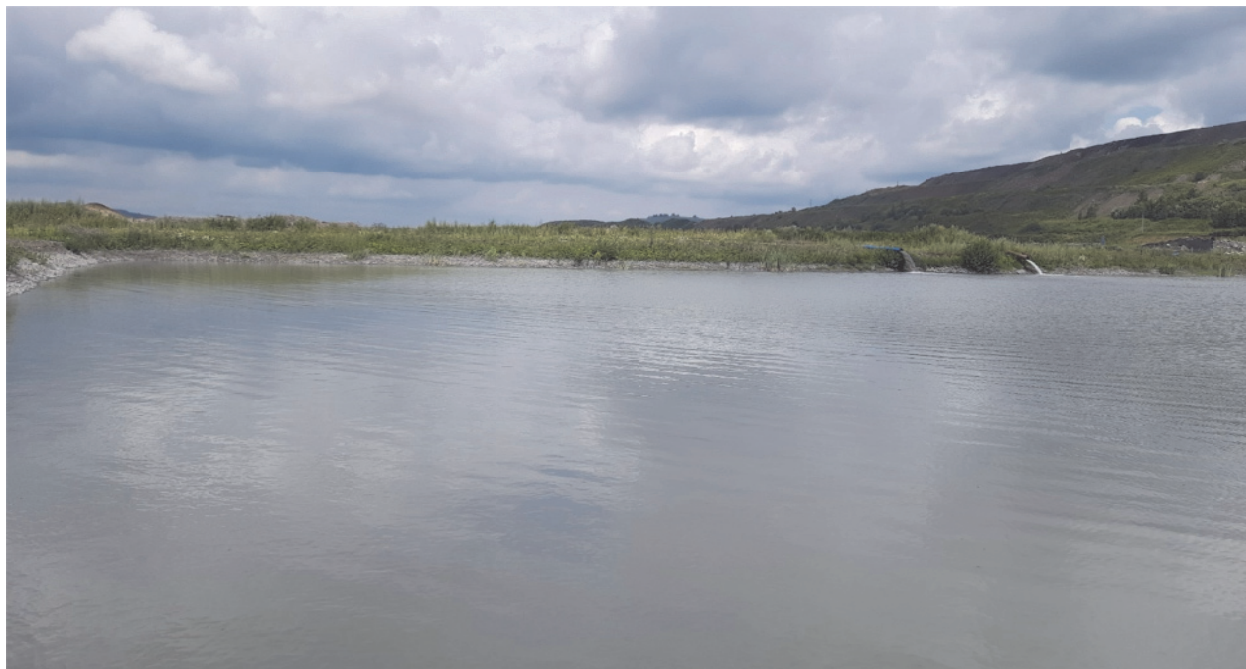
Рис. 2. Общий вид приемного резервуара очистных сооружений
