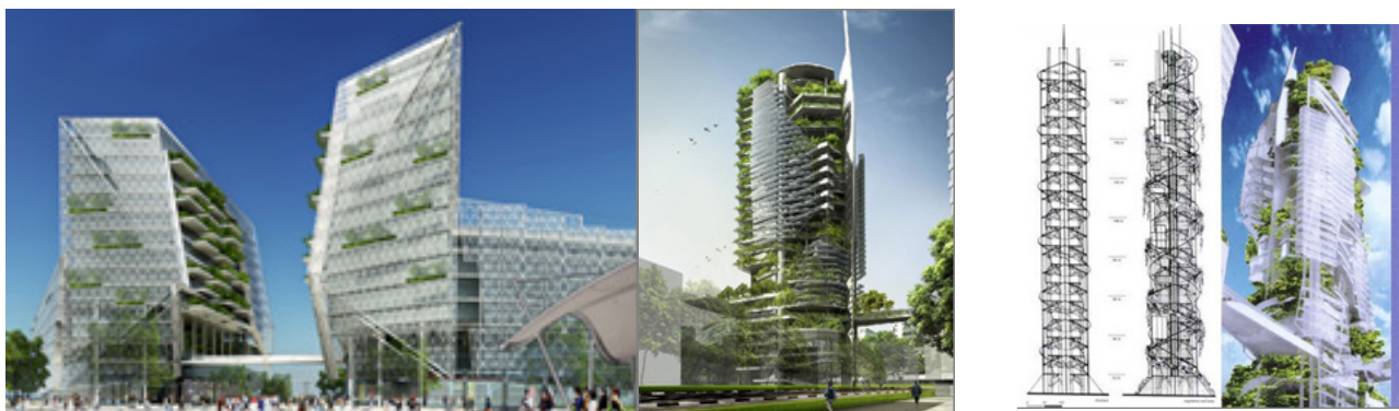
Рис. 3 А – «Петроджава 2C5», Малайзия; В – «ЭДИТТ Тауэр», Сингапур; С – проект «Башня Нара» в Токио, Арх. Кен Янг, фото.: T.R. Hamzah & Yeang Sdn. Bhd. (2014). А – «Putrajaya Lot 2C5»; В – «EDITT »; С – «Nara Tower» arch. Ken Yeang
