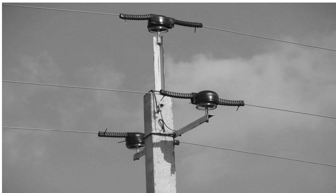
Рис. 2. Опора ВЛ-10кВ, оснащённая ПЗУ КП-1Б.
