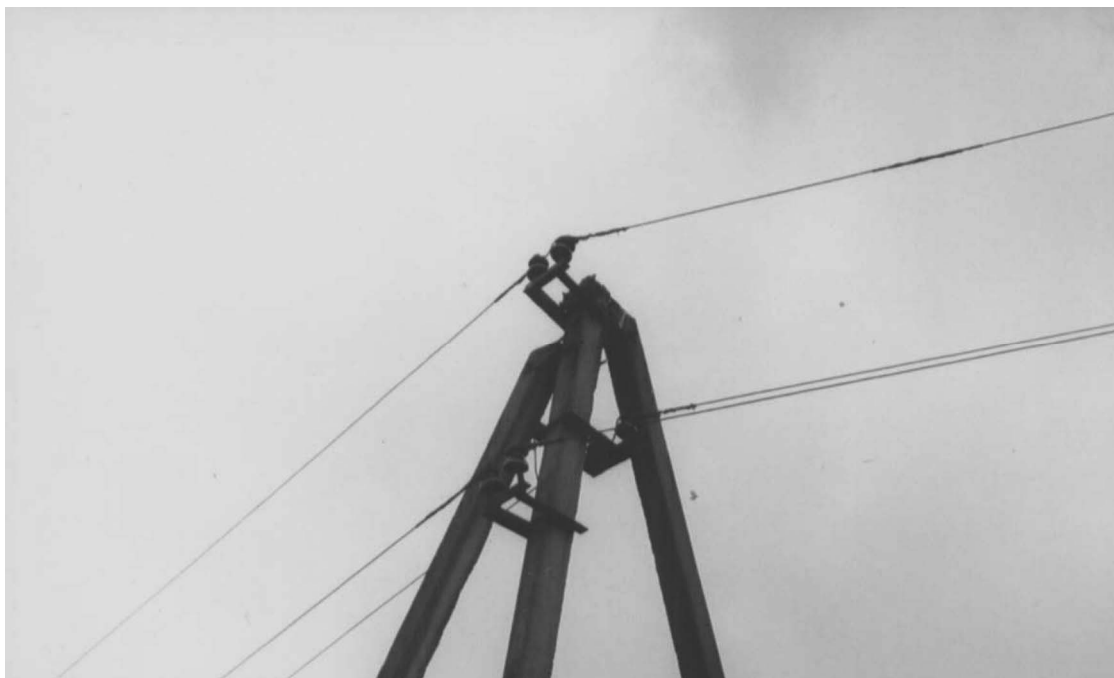
Рис. 1. Птицеопасная опора ВЛ-10кВ
